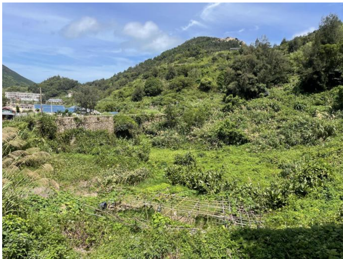
图5.2-13 现状山塘受损，无法蓄水
