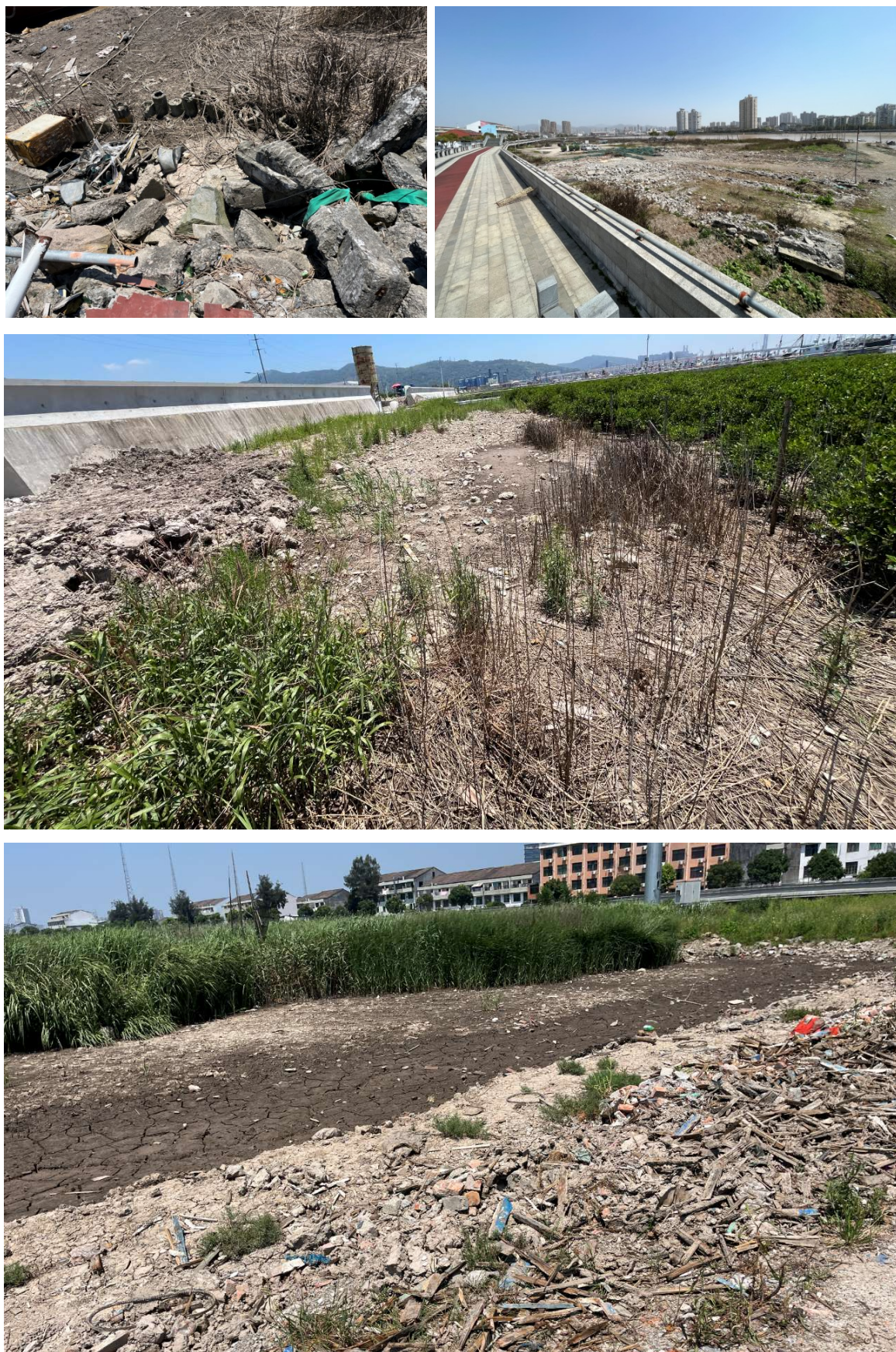
图2.3-15 沿岸建筑、生活垃圾较多
