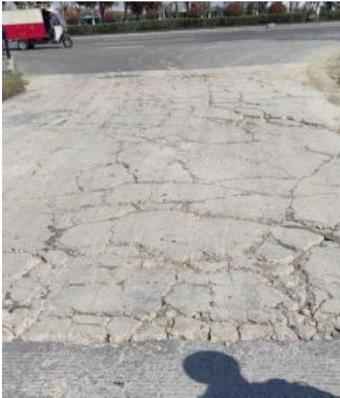
图 6-2 路面情况破损
