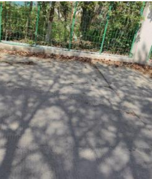
图 6-1 路面情况破板
