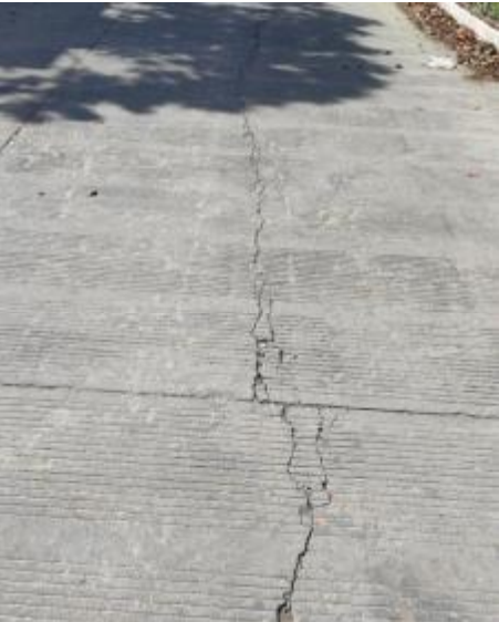
图 6-3 路面情况裂缝图
