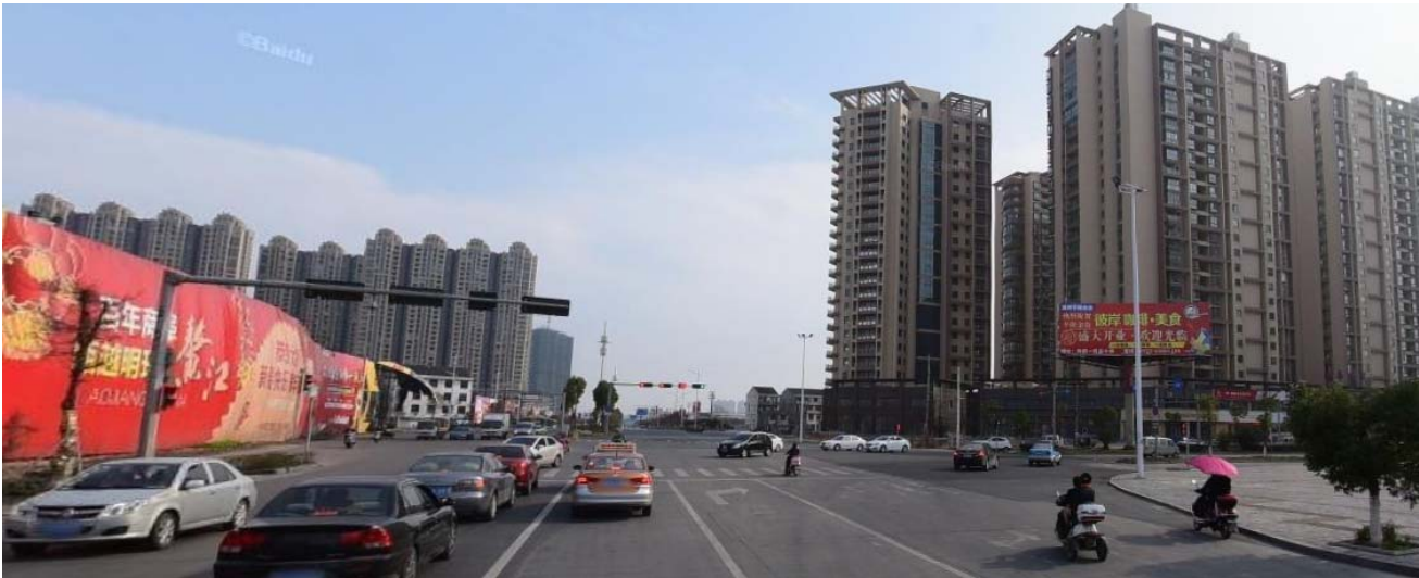
图 2.1-1 本项目工程起点现状交叉口
