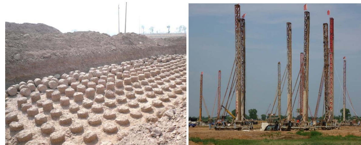
图 6.2-6 水泥搅拌桩成桩
