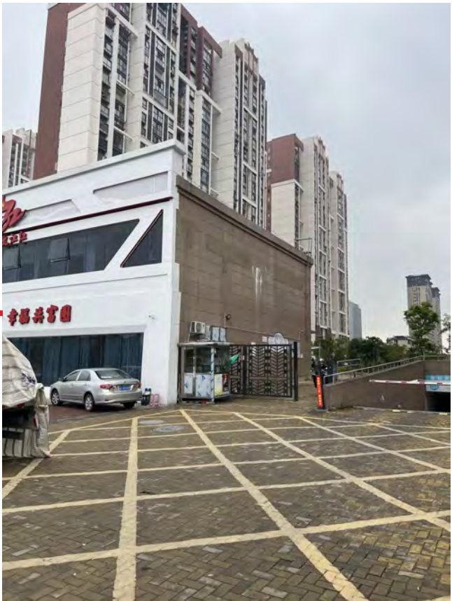
泽丰家园次入口修缮更新
