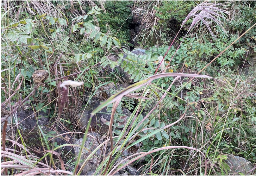
照片 2-1 溪沟现状（镜向 W）
